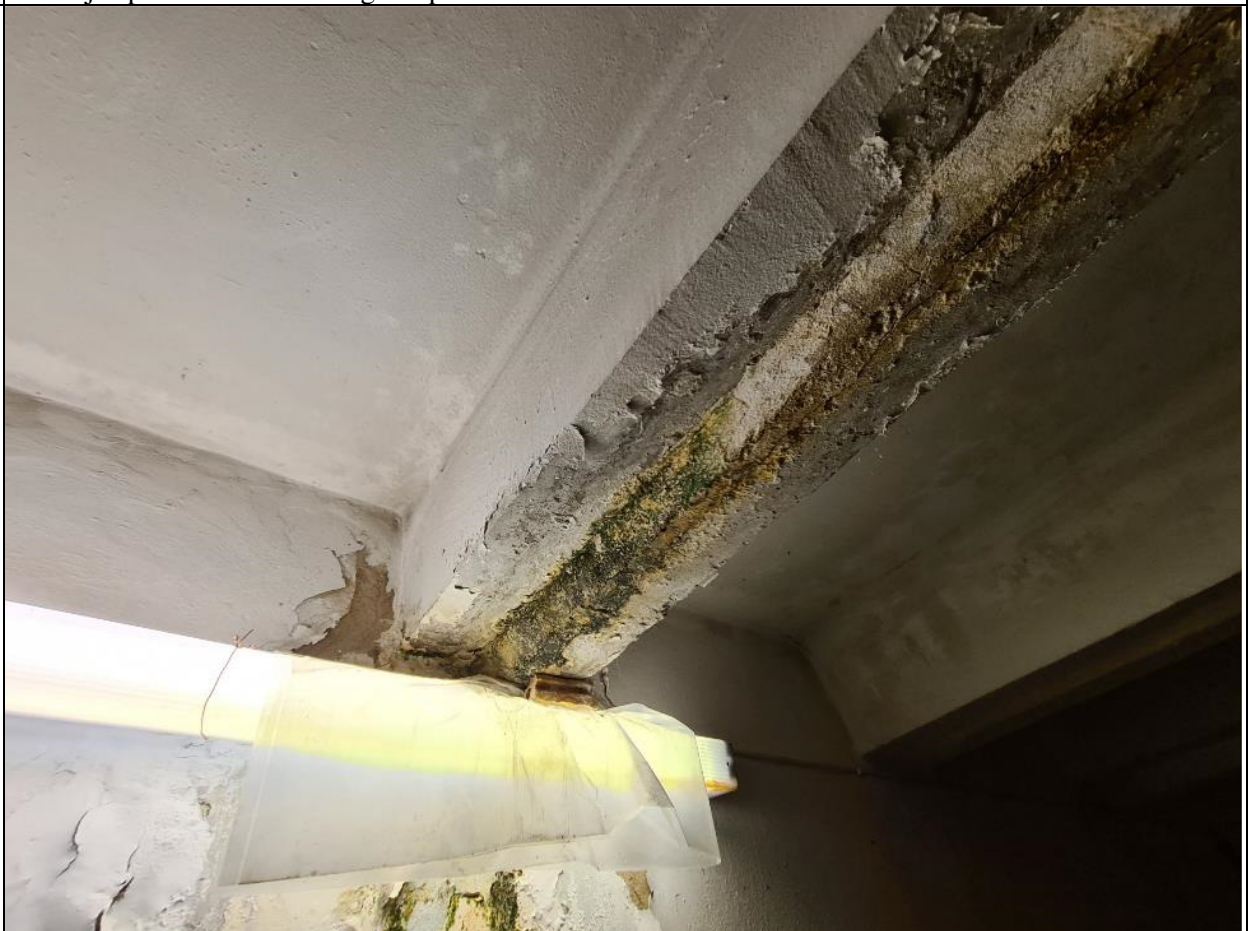
Užfiksuoti išilginiai plyšiai ties denginio plokštės darbine armatūra
