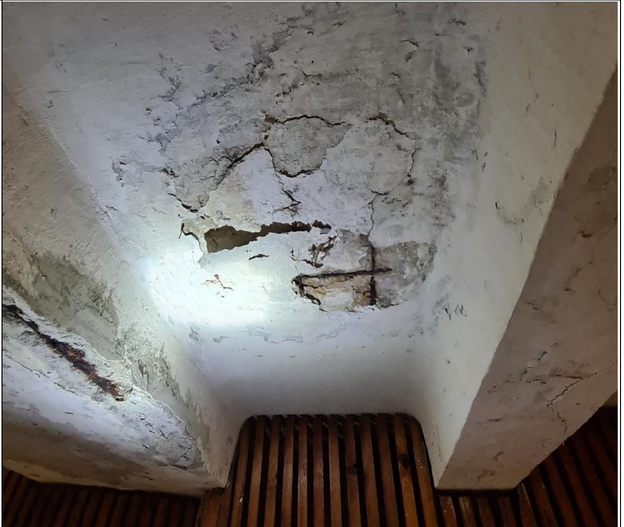
Korozijos pažeista plokštės lentynos armatūra
