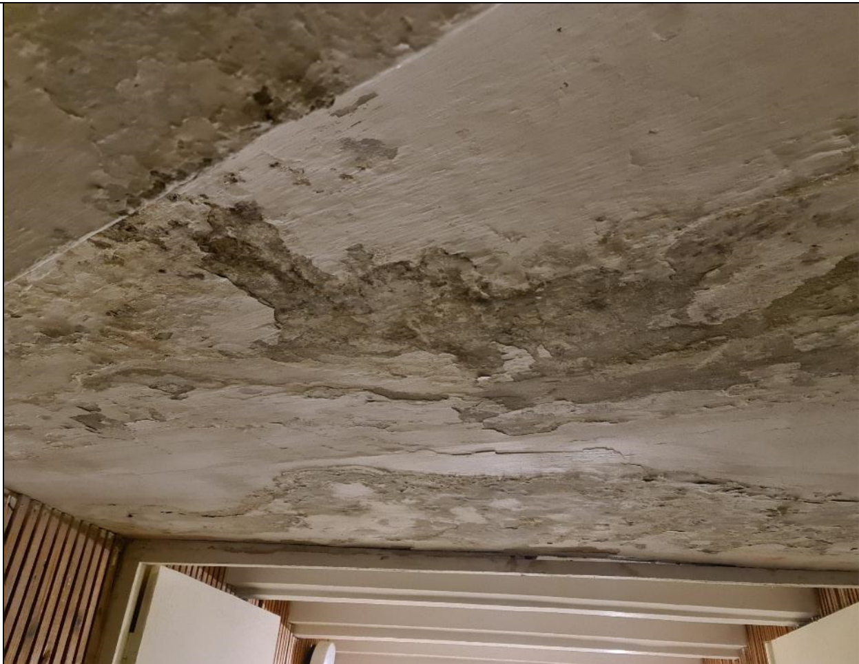
Tunelio denginys – monolitinė dalis ties posūkiu. Matomos vandens pažaidos.
