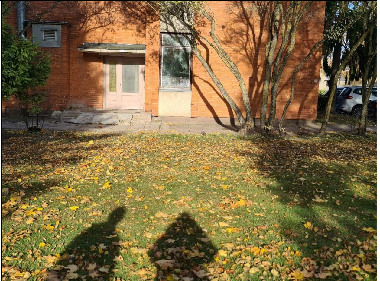
Bendras tunelio vaizdas sklype (ties matoma įduba greta pastato užfiksuotas vandens prasisunkimas)
